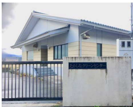
↑高階地区の下水処理場「たかしなクリーンセンター」（池崎町）
